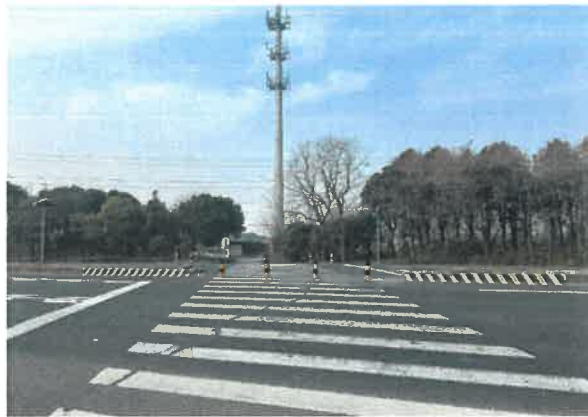
南侧村道交叉口现状
