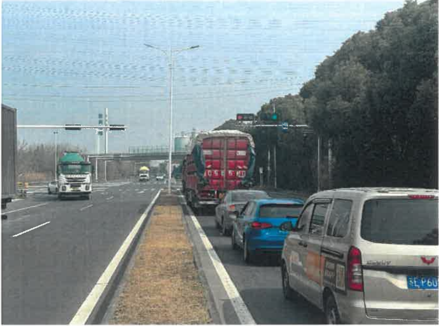
G318 与 S258 交叉口西侧进口道现状
